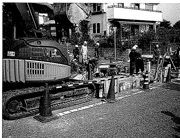
掘削機バックホウで作業も効率よく進む
