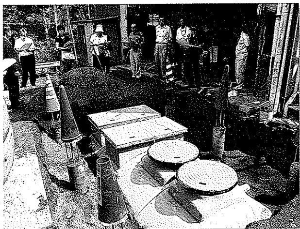
5人槽の必要スペースは縦2.5メートル×横1.3メートル(写真は18人槽)
