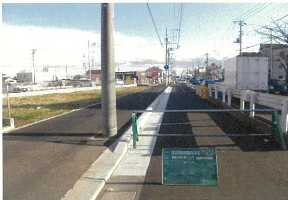
令和6年度歩道整備状況
