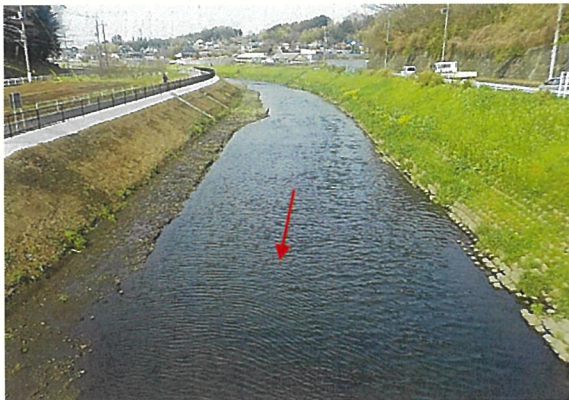
道庵橋上流(整備中)
