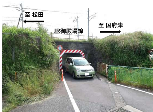
着工前の状況
