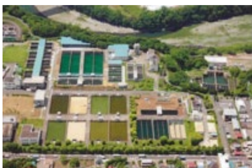
谷ヶ原浄水場
