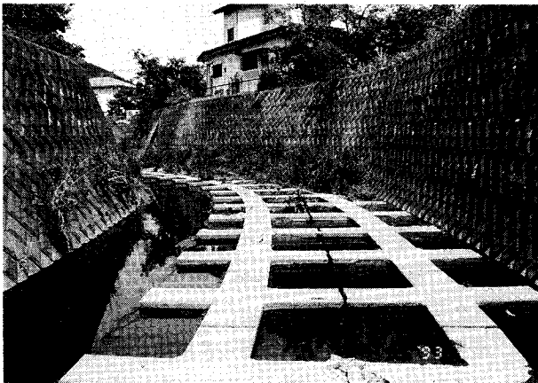
写真3 根固めが施工されたところの景観
