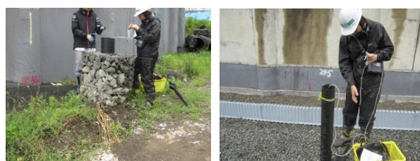
写真1 ガス抜き管での調査の状況
