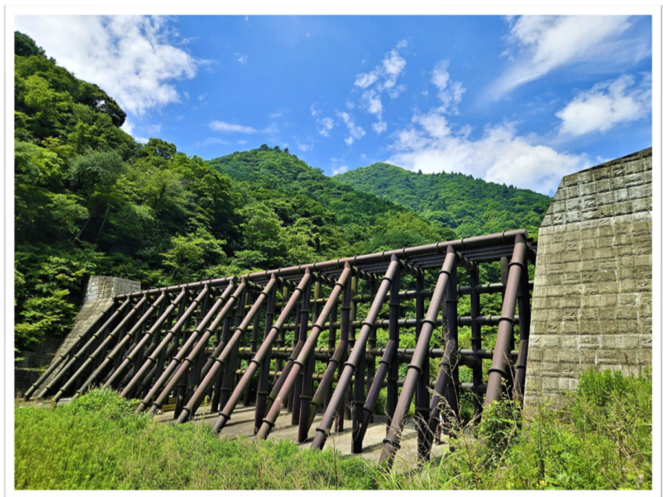
ろうそうぼう えんてい 老僧坊第二堰堤（湯河原町）令和6年6月撮影
