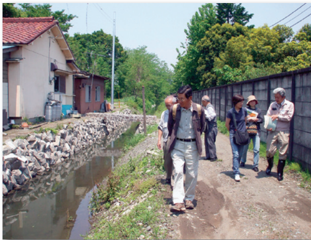
空積護岸等整備現場
