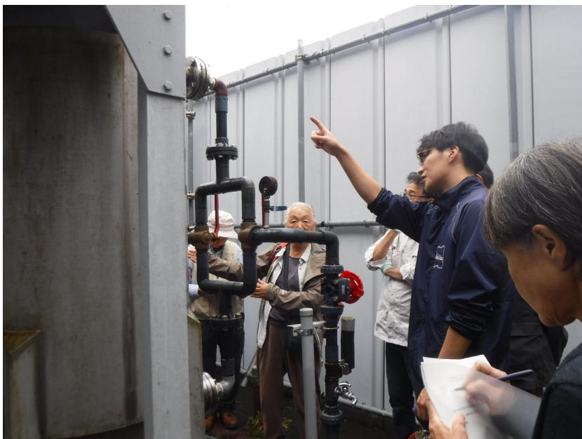
▲現場視察（地下水浄化装置の説明）
