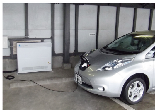
よこすかみづ けんせいそうごう (横須賀三浦地域県政総合センターに設置した蓄電システム)
