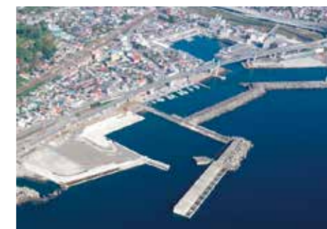
整備が進む小田原漁港
