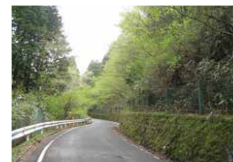
南足柄市と箱根町を連絡する道路の整備
