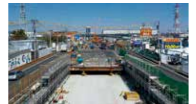
国道129号(戸田立体)の整備
