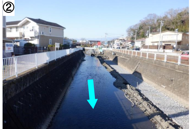
②の写真は、1月16日(金)に左岸側の根固工が完了した時の状況です。
