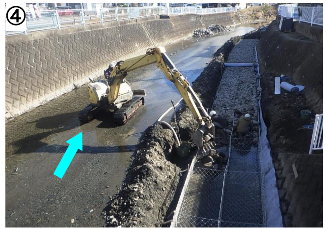
④の写真では、左岸側の根固工が完了しており、右岸側の根固工を施工するため、かごマットに割栗石を敷詰めています。
