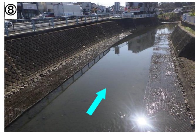
⑧の写真は、新田橋下流側の状況です。
