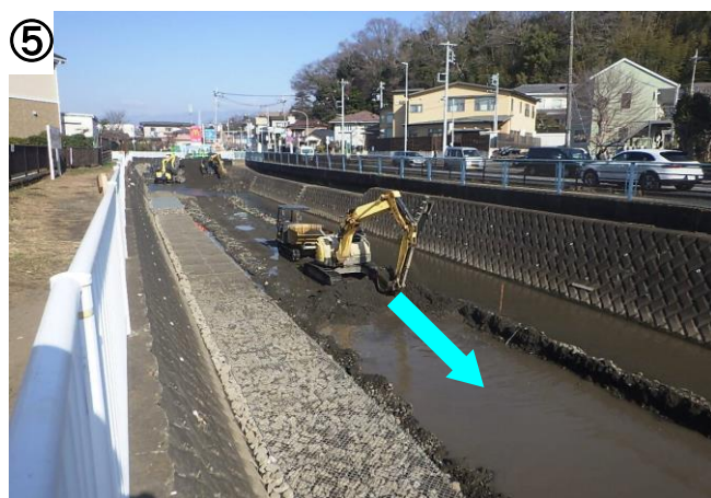
⑤の写真では、新田橋上流部において右岸側の根固工が完了し、川の中央部の掘削を行っています。
