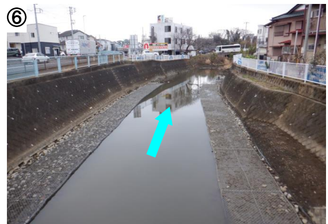
⑥の写真では、新田橋下流部において川の中央部の掘削が完了しました。
