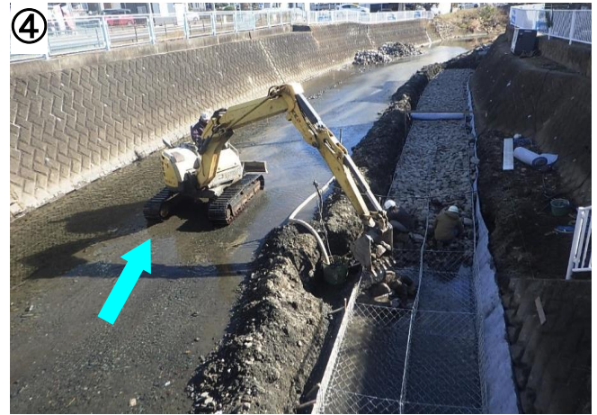
④の写真では、左岸側の根固工が完成しており、右岸側の根固工を施工するため、かごマットに割栗石を敷詰めています。
