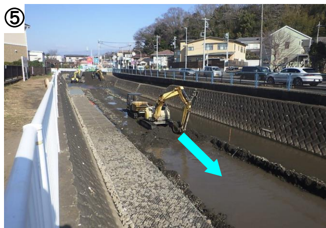
⑤の写真では、新田橋上流部において右岸側の根固工が完成し、川の中央部の掘削を行っています。
