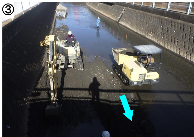
③の写真では、右岸側に根固工を施工するために、河床を掘削しています。
