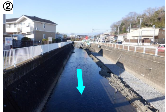
②の写真は、1月16日(金)に左岸側の根固工が完成した時の状況です。
