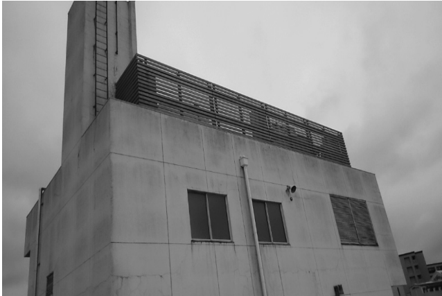
写真7 新館屋上塔屋
