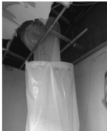
平成26年6月7日の地下講堂での雨漏り事故（事故後にビニール袋で対応した状況）
