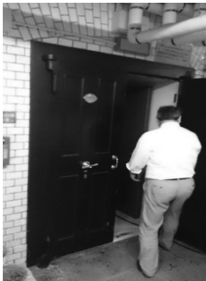
写真8 収蔵庫の扉(旧横浜正金銀行本店時代の金庫を利用)
