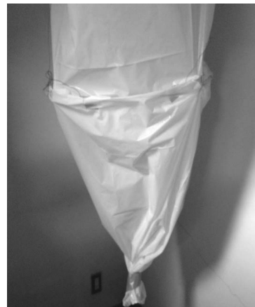
平成26年6月7日の地下講堂での雨漏り事故（事故後にビニール袋で対応した状況）
