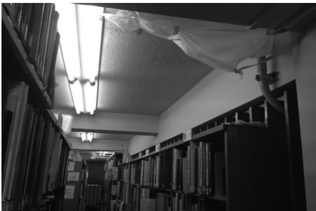
写真5 4階社史室の天井
