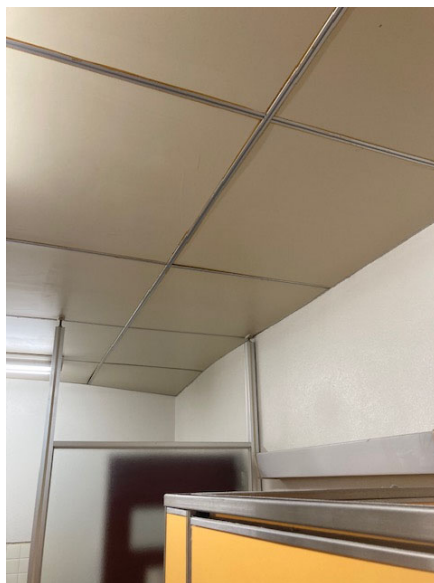
実習棟 2階 (男女トイレ)
