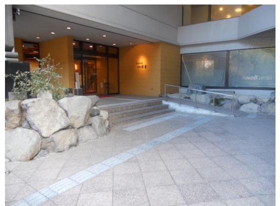
写真2 「玄関周辺での誘導ブロックとスロープの設置」
