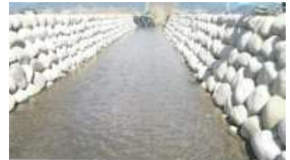
生態系に配慮した石積みの護岸 (南足柄市 清水川)
