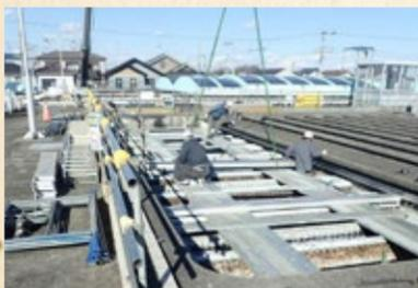
沈でん池上部に鋼材を設置している様子
