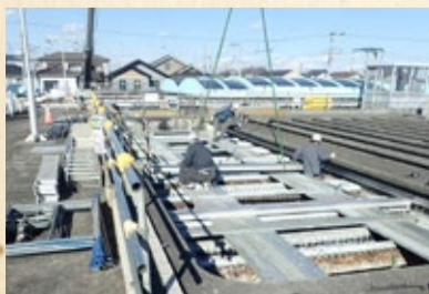
沈でん池上部に鋼材を設置している様子
