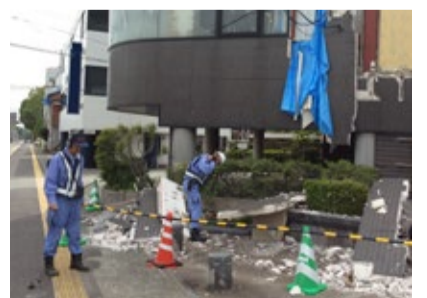
写真：被災地での漏水調査は二人一組で行われます。一人が安全を確認しながら、もう一人が作業。余震時の避難場所の確認など日常の調査とは異なります。
