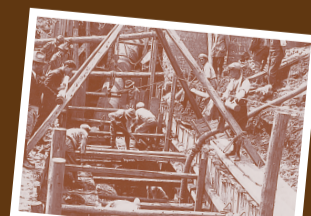
▲写真：水道管をうる様子（昭和初期、湘南地方）
