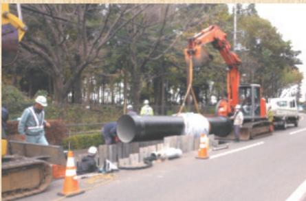
掘り進めながら、水道管を布設する工事を行うことで、道路の掘削を最小限に抑えています。
