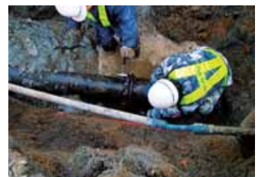
被災地での水道管の修理作業
