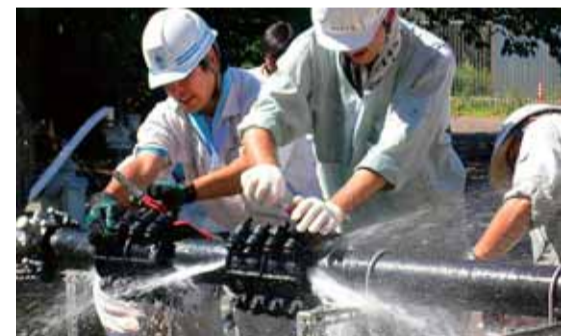
管工事組合との災害対策訓練（漏水修理）
