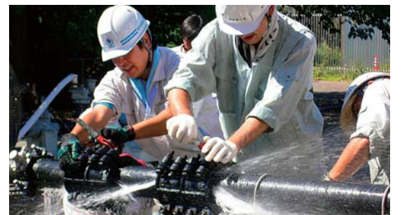
災害対策訓練 (漏水修理)▶
