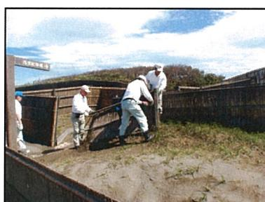
強風によって倒壊した竹柵修繕
