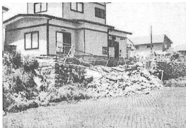
(雑割石が部分的に崩壊したもの)
