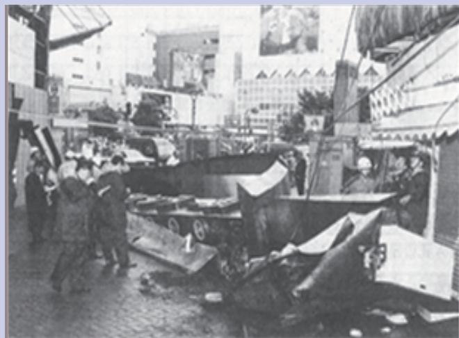
台風で落下した時の様子
