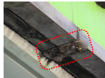
金具が劣化した状態
