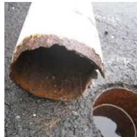
ポール看板の倒壊
