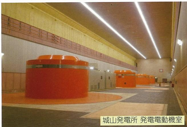
城山発電所は、日本初の大規模な純揚水式発電所として、昭和40年10月に運転を開始しました。下池である津久井湖(城山ダム)の水を、夜間電力をを利用して、上池である城山湖(本沢ダム)にくみ揚げ(揚水)ておき、電力需給ひつ迫時等必要なときに、その水を使って発電をするものです。
