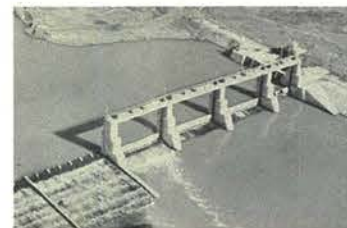
寒川取水施設
