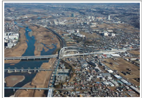
建設中のさがみ縦貫道路
