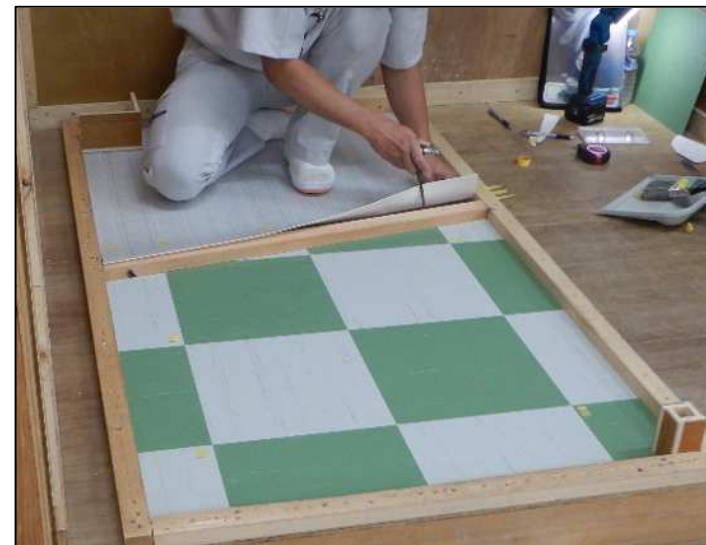
内装施工（床仕上げ）
