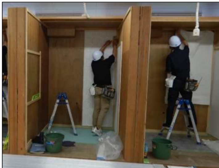
内装施工（壁装）
