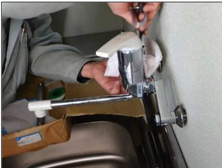
給排水設備工事 (器具取付け)
