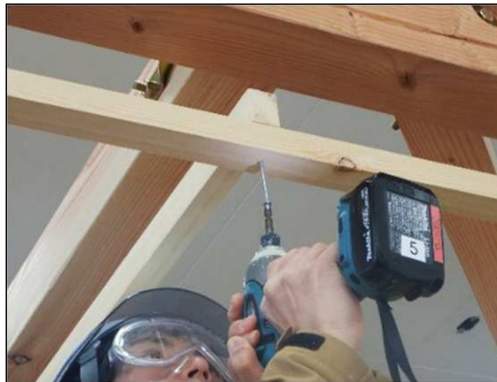
建築施工総合実習
