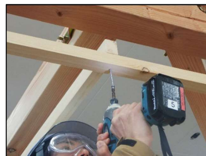
建築施工総合実習
