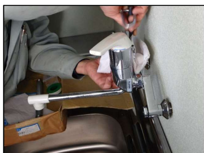
給排水設備工事 (器具取付け)
