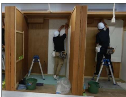
内装施工 (壁装)
