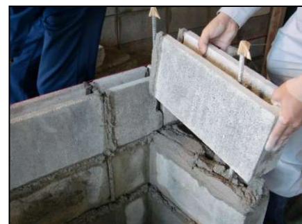
ブロック施工実習
