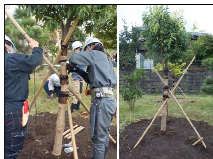
支柱施工実習
