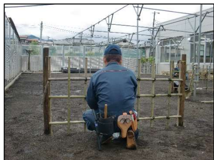
垣根施工実習（四ツ目垣）
