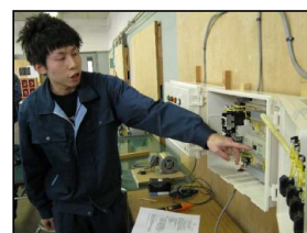
応用実習（工場電気設備組立）
