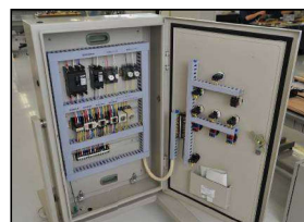
制御盤組立実習
