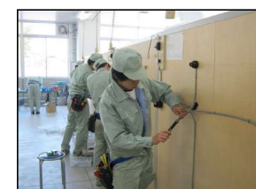
電気工事実習
