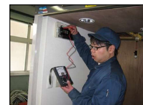
応用実習（模擬家の電気工事）
