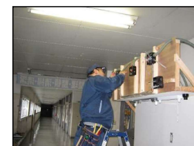
応用実習（電気工事）
