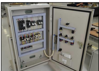
制御盤組立実習
