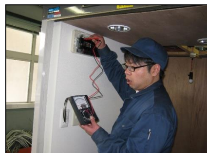
応用実習 (模擬家屋の電気工事)
