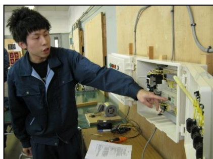
応用実習 (工場電気設備組立)
