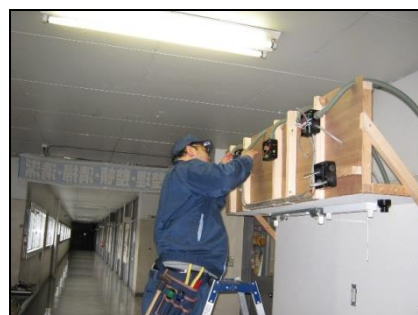
応用実習 (電気工事)
