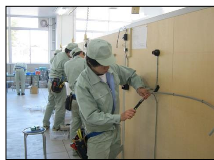
電気工事実習
