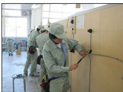
電気工事実習
