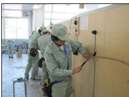
電気工事実習
