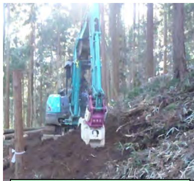
ザウルスによる作業道作設
