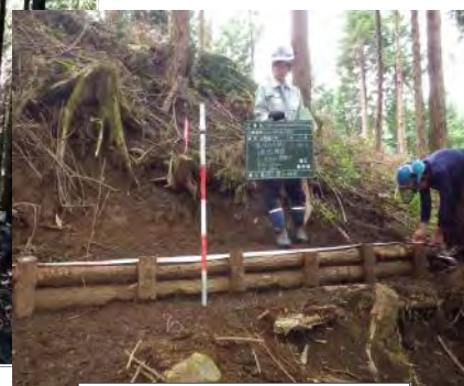
現採丸太筋工完成確認
