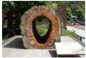
平成13(2001)年に日本大通りで発見された明治10年代に設置されたレンガづくりの下水管。一定の流速を保つために卵形となっている。
