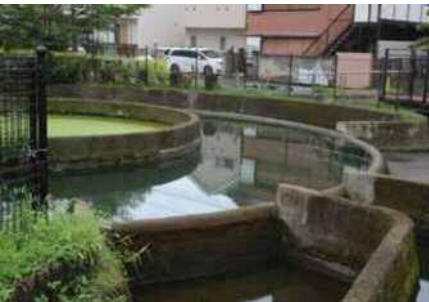
多摩川の2カ所から取水された用水は久地で合流し、下流の「久地円筒分水」で四つの堀に分水される。用水を平瀬川の下をくぐらせ、再び噴出させた水を、放水部円筒を4地区の灌漑面積の比率で正確に4分割して流す。昭和16(1941)年に県の技師・平賀栄治が設計したもので、国の登録有形文化財。
