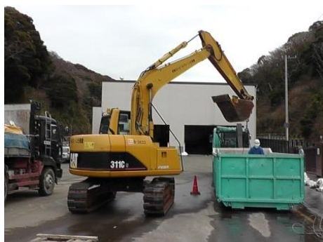
写真7（吊り作業場所）
