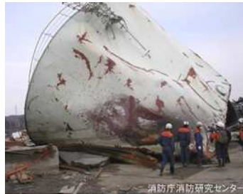
津波によるタンク転倒
