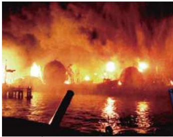
高圧ガス貯槽の爆発火災
