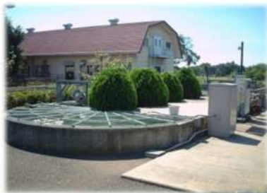
家畜用浄化槽
