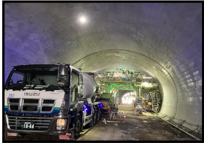
⑰二次覆工コンクリート打設 (現在)
