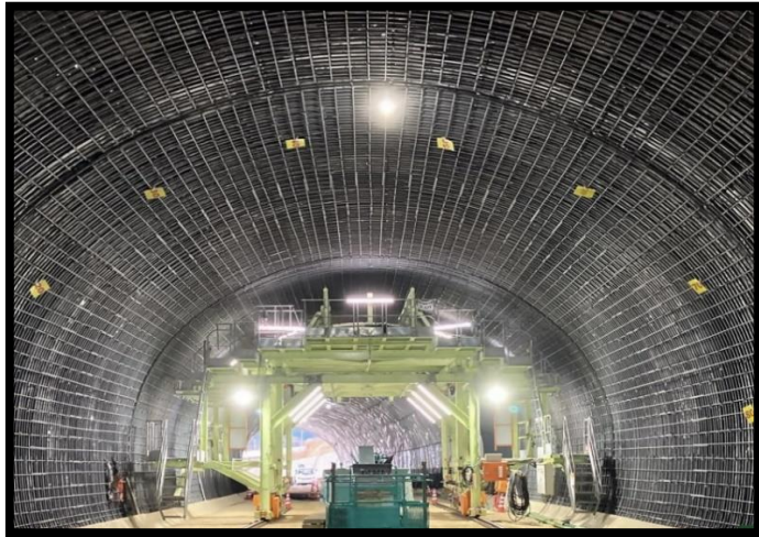
⑯二次覆工鉄筋組立
