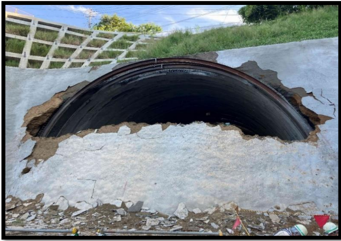
⑬貫通状況 (終点坑口)
