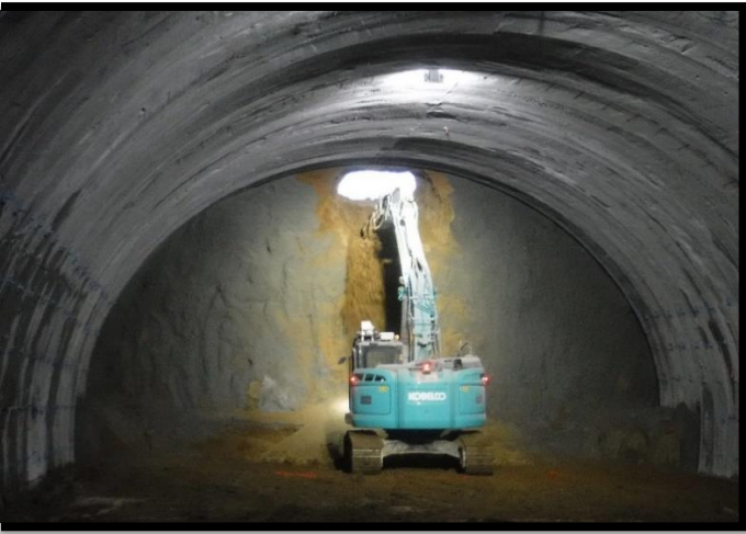
⑬トンネル貫通 (R6. 6. 18)
