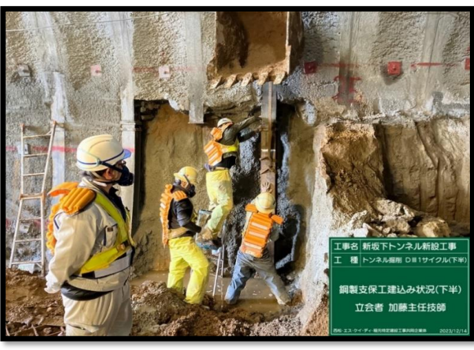
⑧支保工下半建込み
