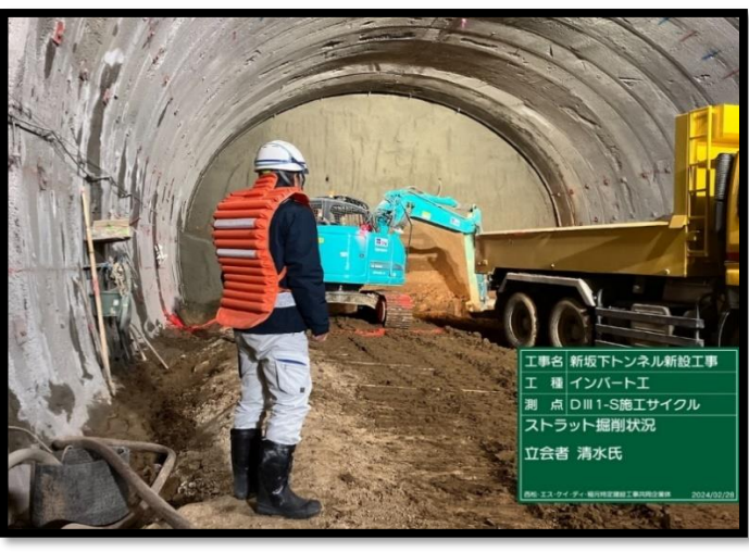
⑨インバート掘削
