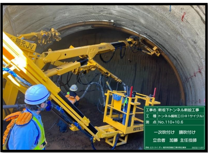
⑤掘削面コンクリート吹付
