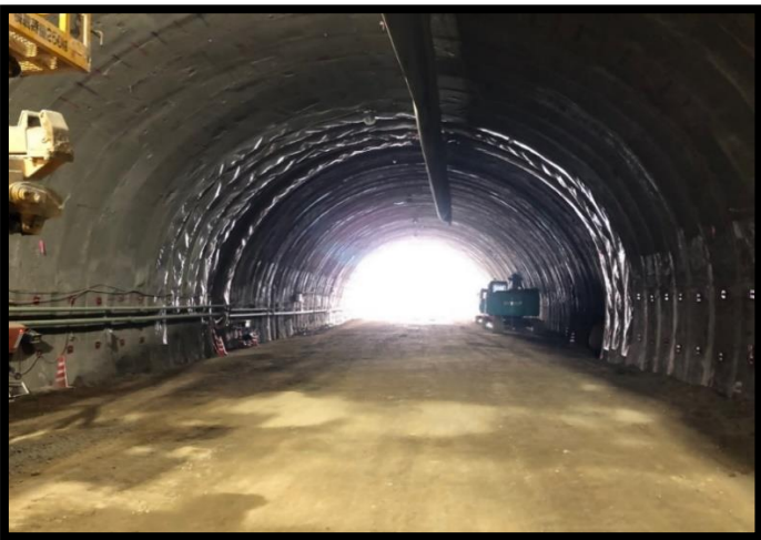
⑬貫通状況
