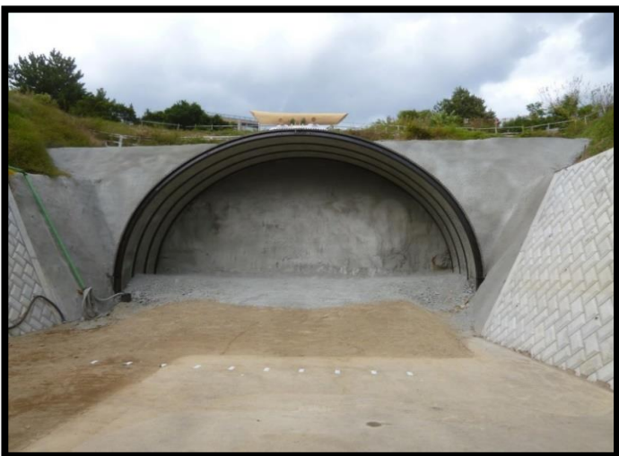
②坑口付け
