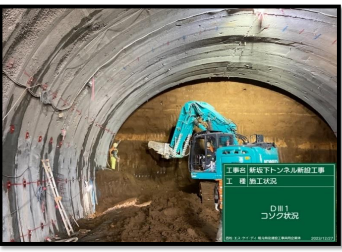
⑦トンネル下半掘削
