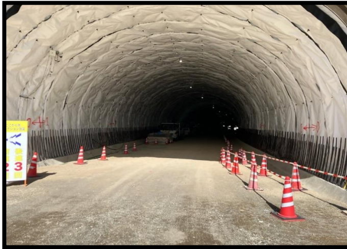
⑮トンネル内面防水シート施工
