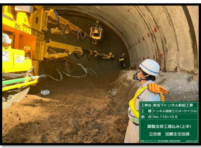
⑥トンネル上半掘削・支保工上半建込み
