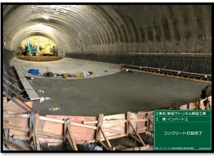
⑪インバートコンクリート打設
