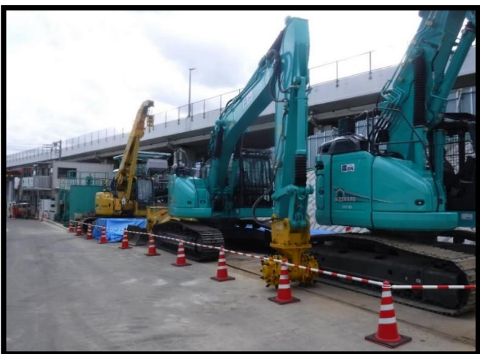
③トンネル掘削機械等搬入
