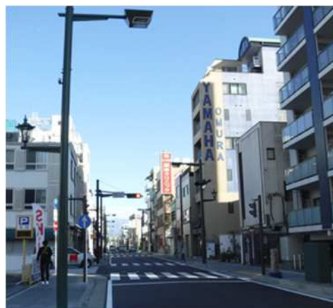
【完了区間状況】
