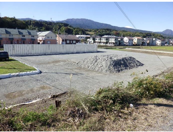
狩川上流側の右岸堤防から南側を望む
