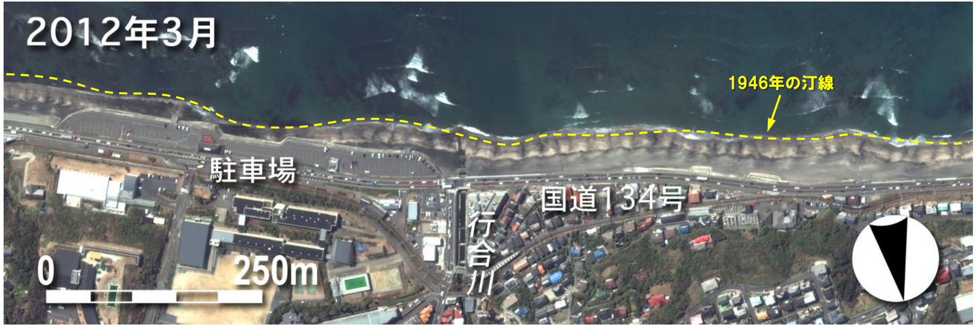
図1.10 行合川河口部の空中写真（1946～2012年）
