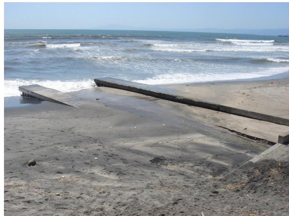
図5.2 駐車場西側に堆積した飛砂
