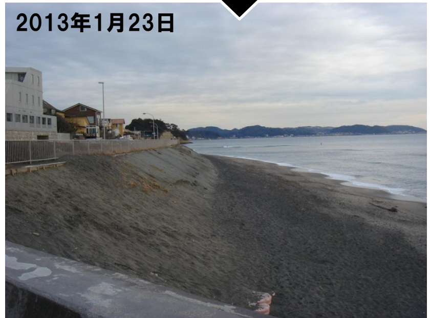
図1.9 現地写真による海岸状況の変化
