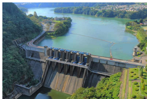
城山ダムと貯水池
